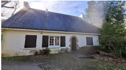
Photo PhDPE013 Ouvrage :
