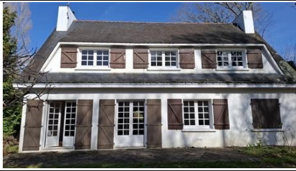
Photo PhDPE013 Ouvrage :
