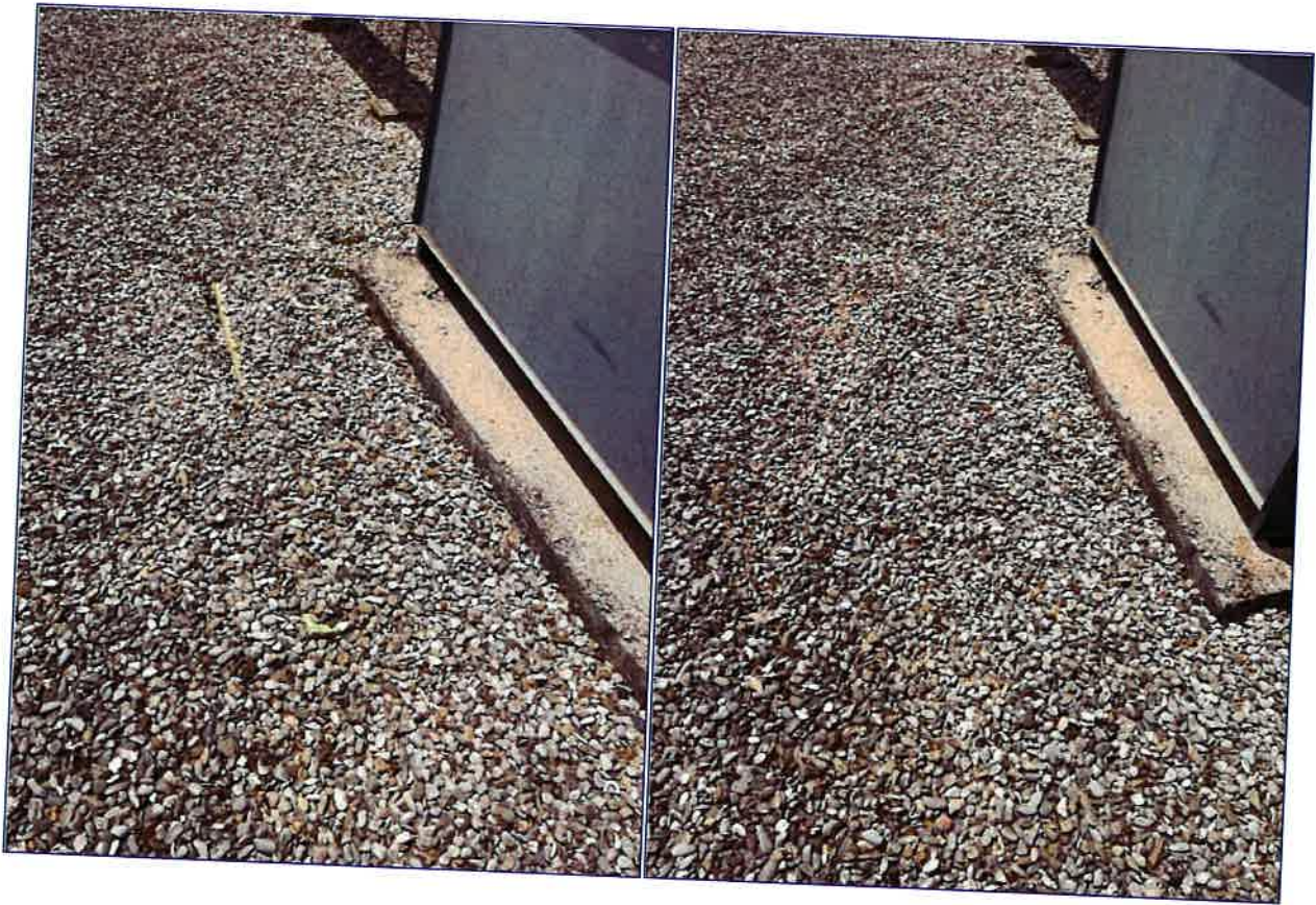
Avant/après remise en place de la protection lourde
