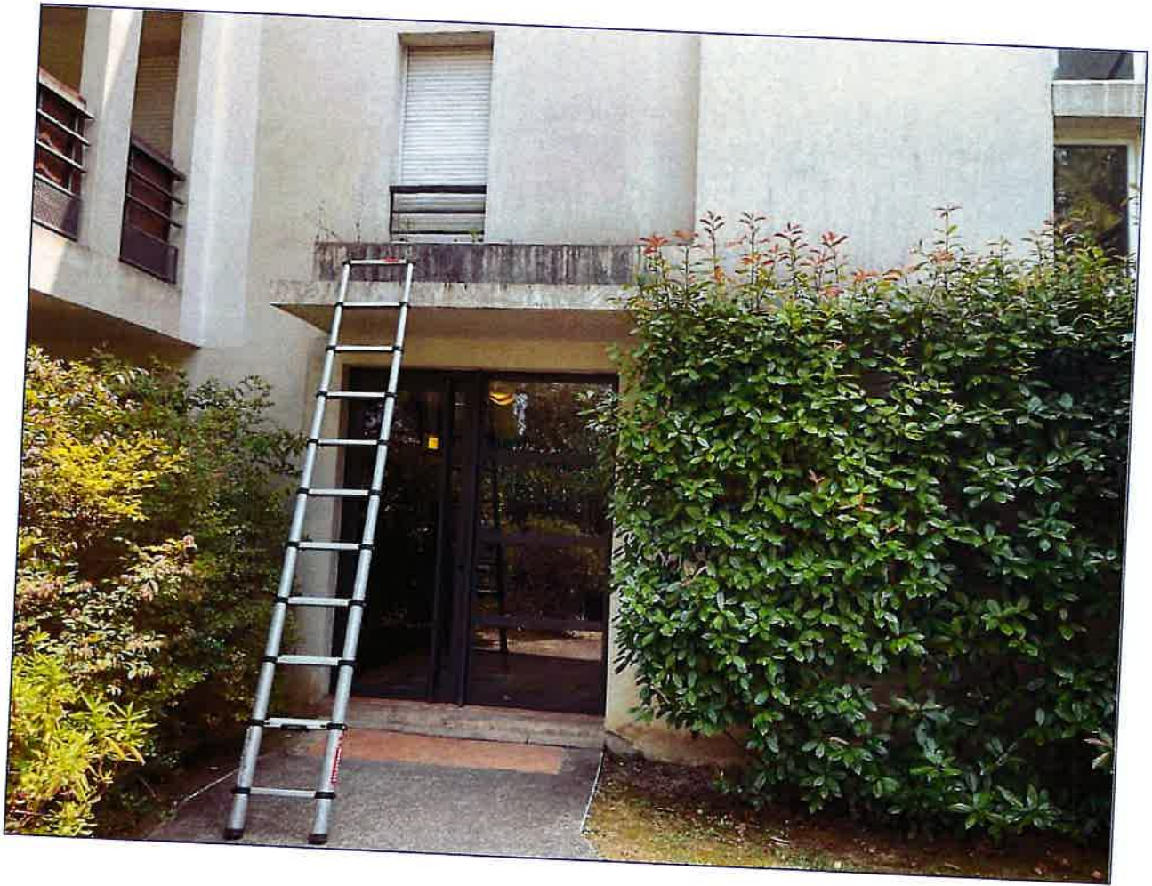
Toiture de l'auvent nettoyé des végétaux
