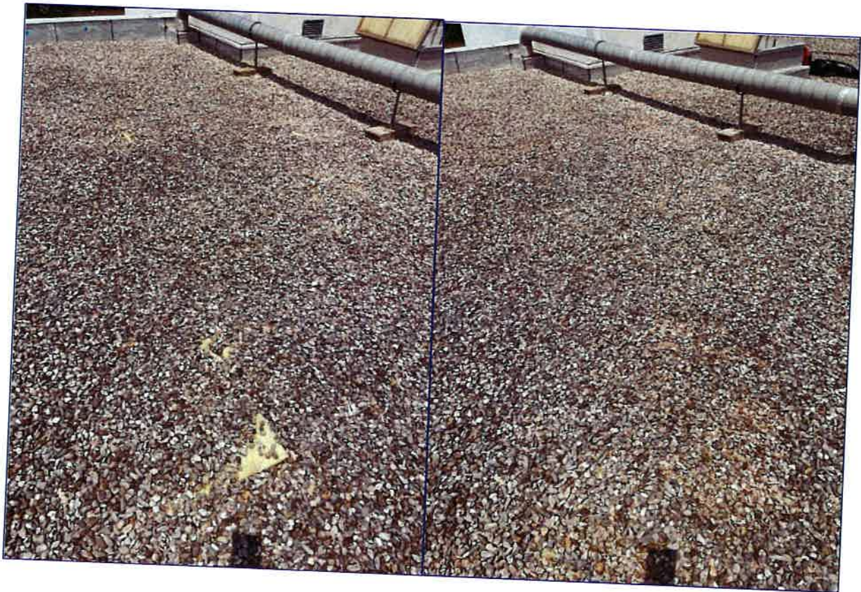
Remise en place de la protection lourde
