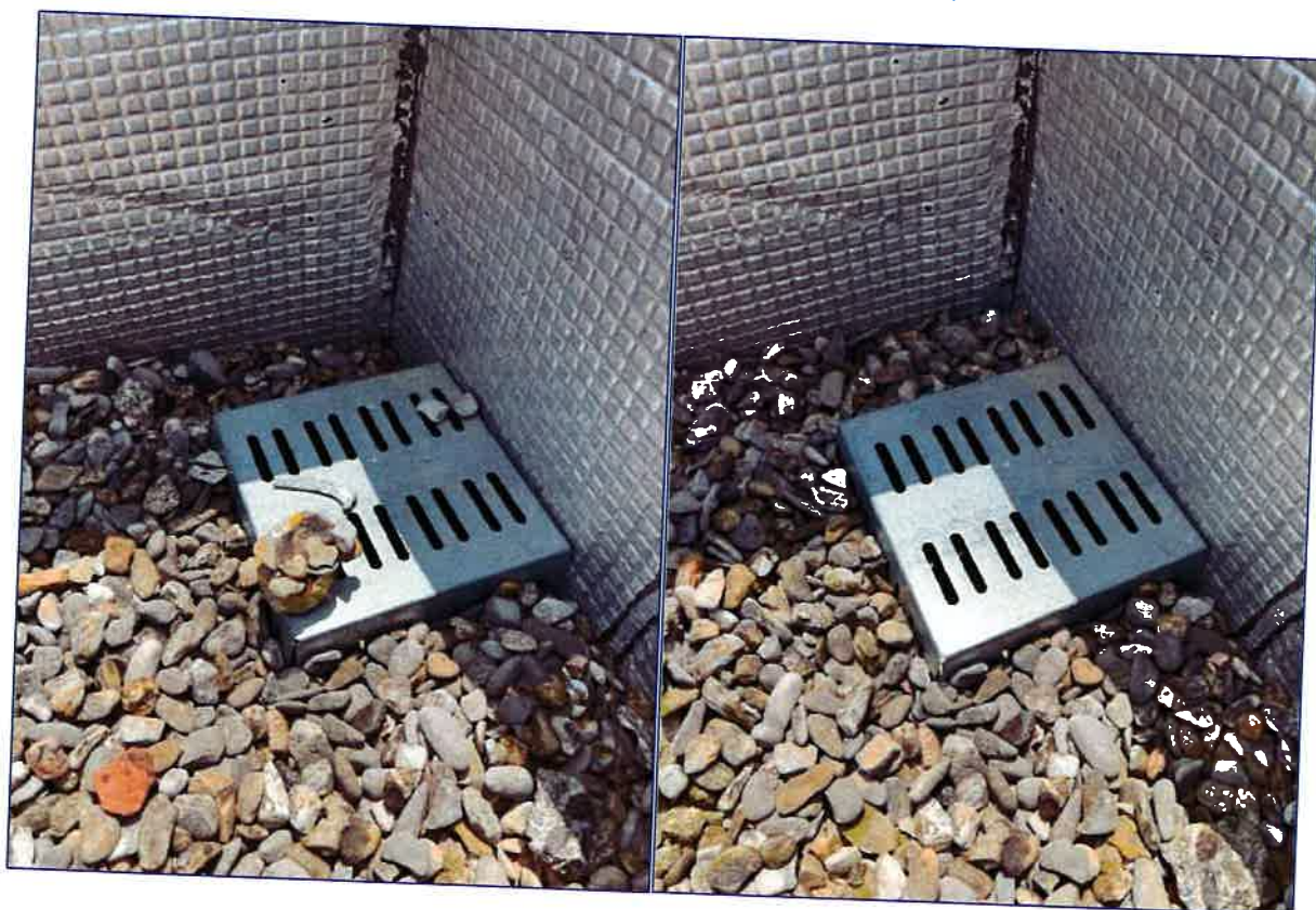
Relevé d'étanchéité défectueux
