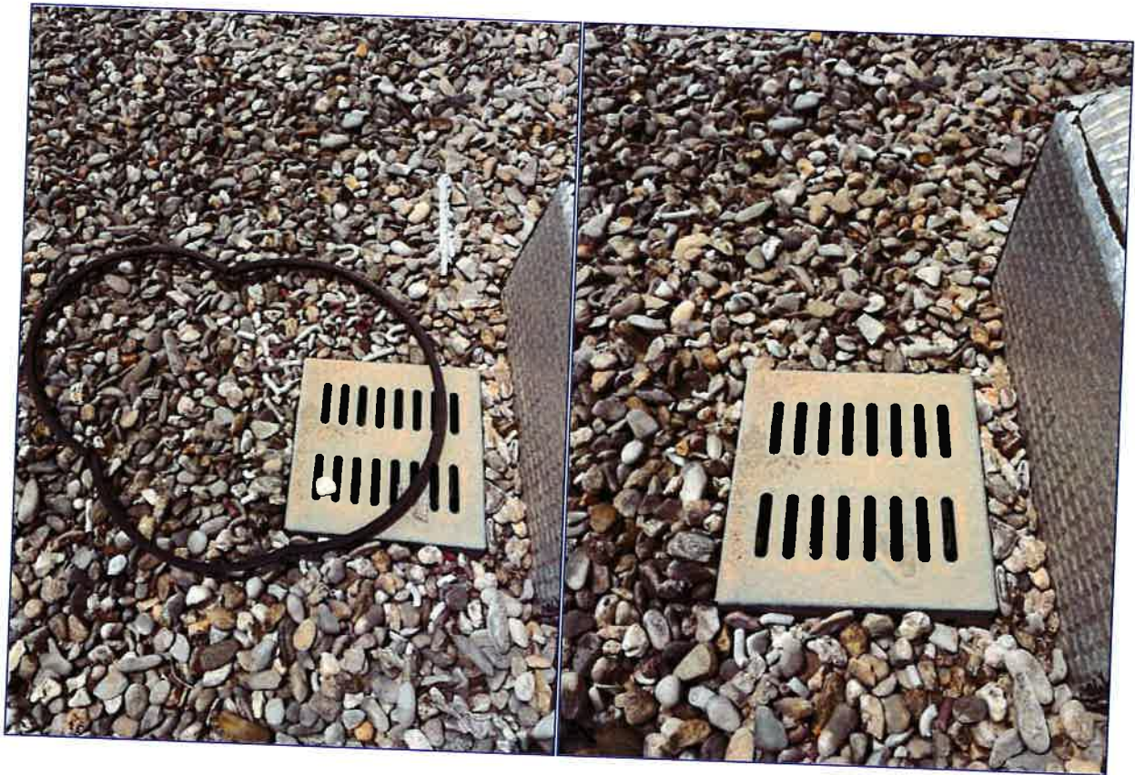
Avant/Après nettoyage de l'évacuation d'eaux pluviales
