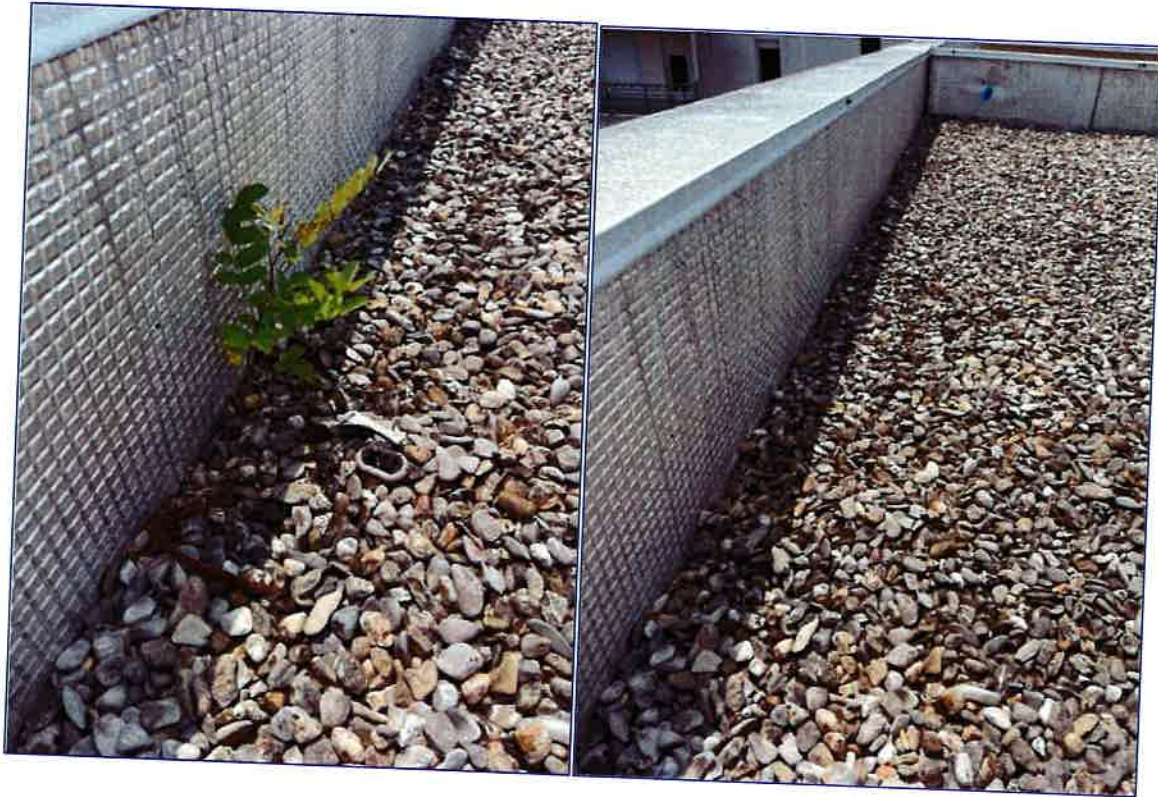
Avant/Après nettoyage des végétaux
