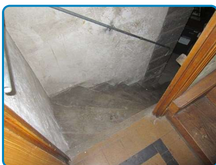
Maison RDC surélevé Cage d'escalier RDC Sous-sol
