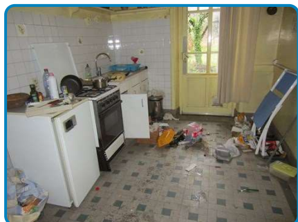
Maison RDC surélevé Cuisine
