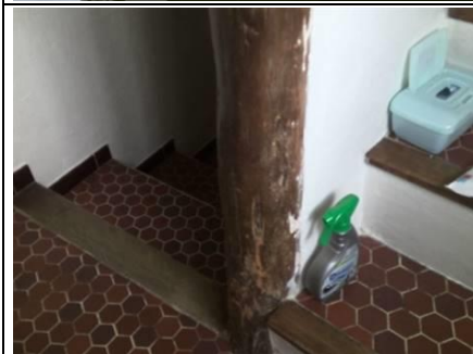
Photo n° PhTer002 Localisation : RdC - Escalier Ouvrage : Boiseries Parasite : Présence d'indices d'infestation d'autres agents de dégradation biologique du bois Indices : altérations dans le bois (dégradation(s) faible(s))
