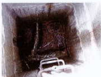
Réseau eaux usées (vue intérieure)
