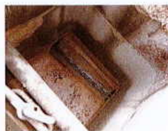
Réseau eaux pluviales (vue intérieure)
