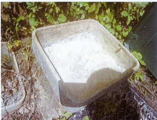
1 Couvercle de Conduit, FIBRES Ciment, en dépôt au sol en Façade arrière de la Maison
