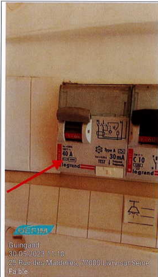
Photo Ph002 Libellé de l'anomalie : B4.3 j1 Le courant assigné de l'interrupteur différentiel placé en aval du disjoncteur de branchement n'est pas adapté.
