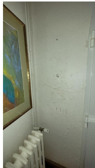
Entrée (Murs) : Enduit cloqué soufflé
