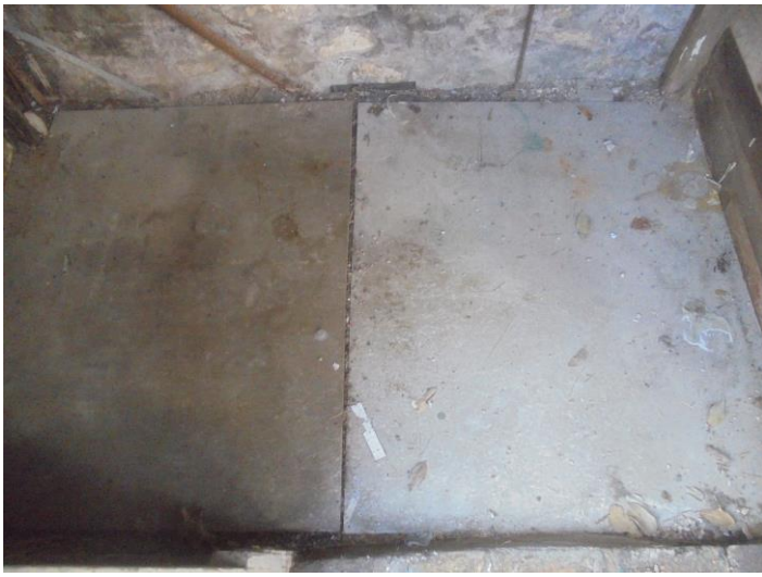
2 Plaques planes, FIBRES Ciment, en dépôt au sol dans le Cabanon
