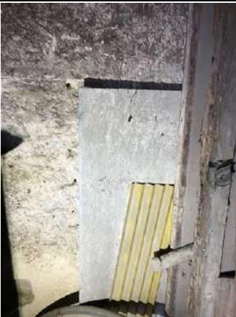
Photo n° PhA004 Localisation : Extérieur - Jardin; Extérieur - Garage (présence de mobilier lourd) Ouvrage : Éléments libres déplaçables Partie d'ouvrage : Éléments libres déplaçables de type plaque ondulée/plaque plane Description : Éléments libres déplaçables de type plaque ondulée/plaque plane
