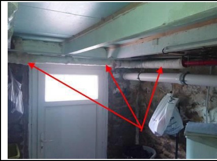
Photo n° PhA002 Localisation : Sous-Sol - Cave Ouvrage : Flocages, Calorifugeages, Faux plafonds Partie d'ouvrage : Calorifugeages Description : Calorifugeages Localisation sur croquis : M002
