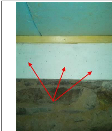
Photo n° PhTer001 Localisation : Sous-Sol - Cave Ouvrage : Plafond - Bois et styrodur Parasite : Anobium punctatum (Petites vrillettes) Indices : présence de trous de sortie Informations complémentaires : plancher haut non visible recouvert styrodur
