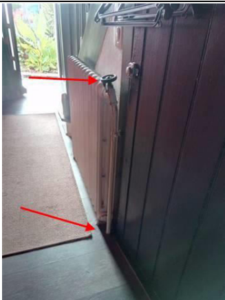
Photo n° PhTer006 Localisation sur croquis : RdC - Entrée Dgt Ouvrage : Sol - Stratifié
