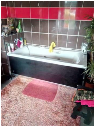
Photo n° PhTer004 Localisation : RdC - Salle de bain Informations complémentaires : Présence d'équipements sanitaires de type baignoire/douche impanté sur plancher : veiller au bon entretien des joints afin d'éviter toute infiltration d'humidité dans la structure.
