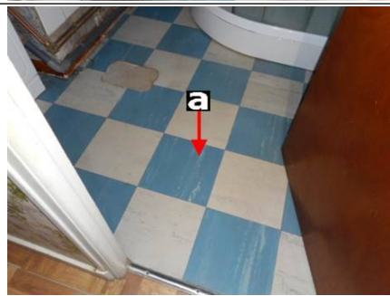
Photo n° Ph005 Localisation : Cuisine; WC 1; Salle d'eau Ouvrage : 5 - Planchers et planchers techniques - Revêtements de sols Partie d'ouvrage : Dalle de sol Description : Matériau semi-dur de type dalle de sol (gris) ; matériau de type colle (jaune) ; matériau semi-dur de type ragréage (gris)
