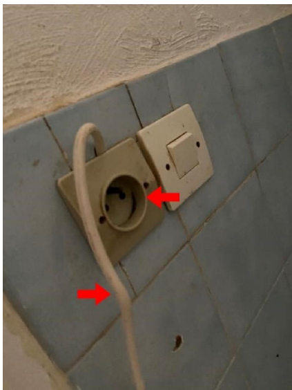
B.11 b2) : Au moins un socle de prise de courant n'est pas de type à obturateur.
