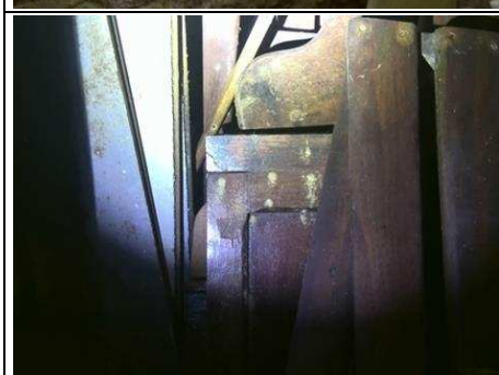
Photo n° PhTer002 Localisation : Sous-Sol - Cave 1 Ouvrage : Arbalétrier Parasite : Insectes à larves xylophages Indices : orifices obturés ou non, présence de vermoulure (présence sur des débris bois au sol) Localisation sur croquis : 002
