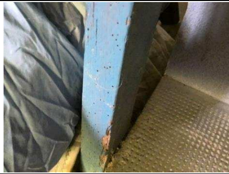
Photo n° PhTer005 Localisation : Rez de jardin - Garage Ouvrage : Garde corps - bois et peinture Parasite : Insectes à larves xylophages Indices : orifices obturés ou non (présence sur tout l'élément concerné) Localisation sur croquis : 005
