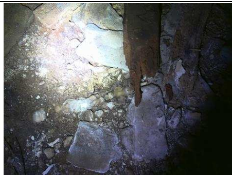
Photo n° PhTer004 Localisation : Sous-Sol - Cave 2 Ouvrage : Sol - terre battue et débris Parasite : --- Champignons lignivores --- Indices : dégradation du bois, présence de fructification (présence sur des débris bois au sol) Localisation sur croquis : 004
