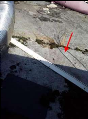
Photo n° PhA004 Localisation : Dépendance Ouvrage : 4. Eléments extérieurs - Toitures Partie d'ouvrage : Bardeaux bitumineux Description : Bardeaux bitumineux Localisation sur croquis : M004
