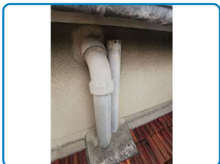
D.O. n° 1 sur Cheminée d'aération Fibres-ciment
