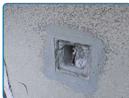
D.O. n° 1 sur Cheminée d'aération Fibres-ciment
