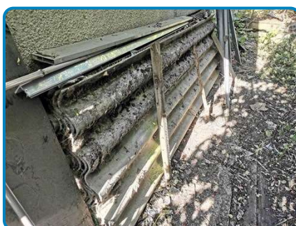
D.O. n° 5 sur Ancienne toiture Plaques fibres ciment
