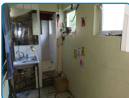
Maison individuelle Rez de chaussée Salle d'eau
