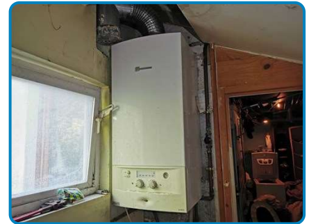
Appareil n°1 (Chaudière mixte) sur installation n°1 (dans Maison individuelle Rez de chaussée Salle d'eau)
