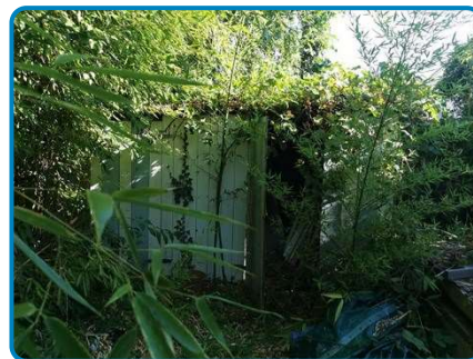
Maison individuelle Extérieur Abri de jardin n°2
