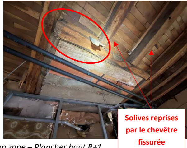
Photographie du désordre en zone – Plancher haut R+1
