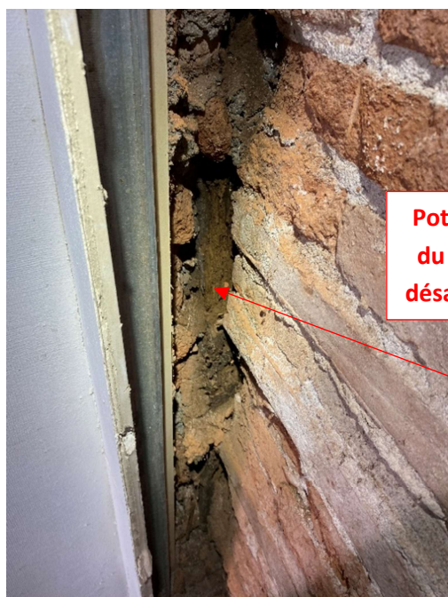
Colombage vertical dans l'angle gauche du bâtiment R+2
