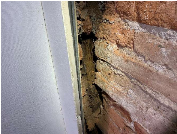
Photographie du poteau d'angle du mur en colombage
