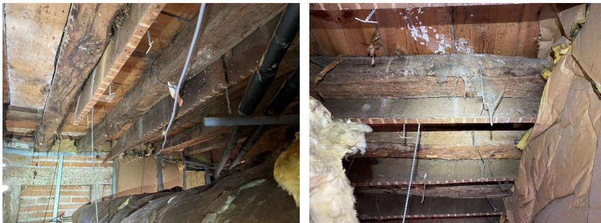
Photographie du plancher de la coupe du sondage S7
