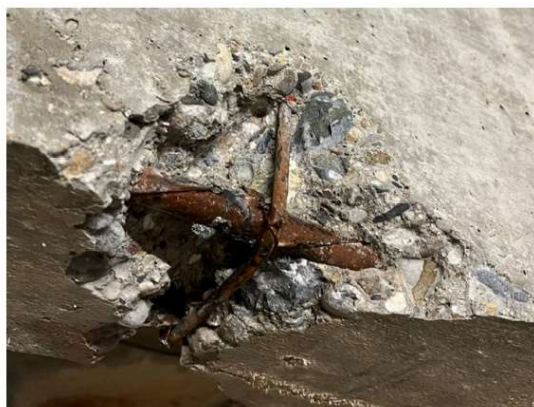
Sondage SP-2 – Sous-face poutre
