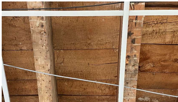
Photographie du plancher de la coupe du sondage S14
