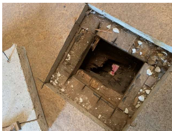
Photographie d'un sondage en sous-face et en surface de plancher
