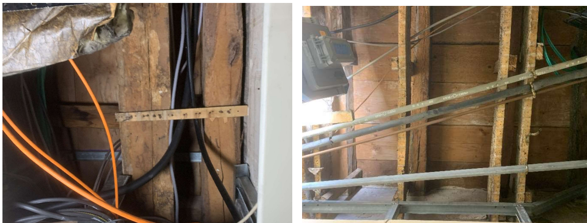
Photographie du plancher au droit de la zone « Sanitaires »
