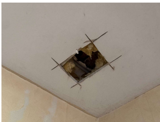
Photographie d'un sondage en sous-face et en surface de plancher
