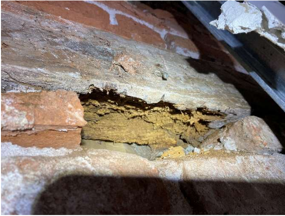
Photographie de poutre de chaînage horizontal du mur en colombage
