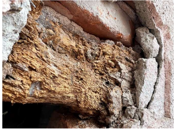
Photographie de poutre de chaînage horizontal du mur en colombage
