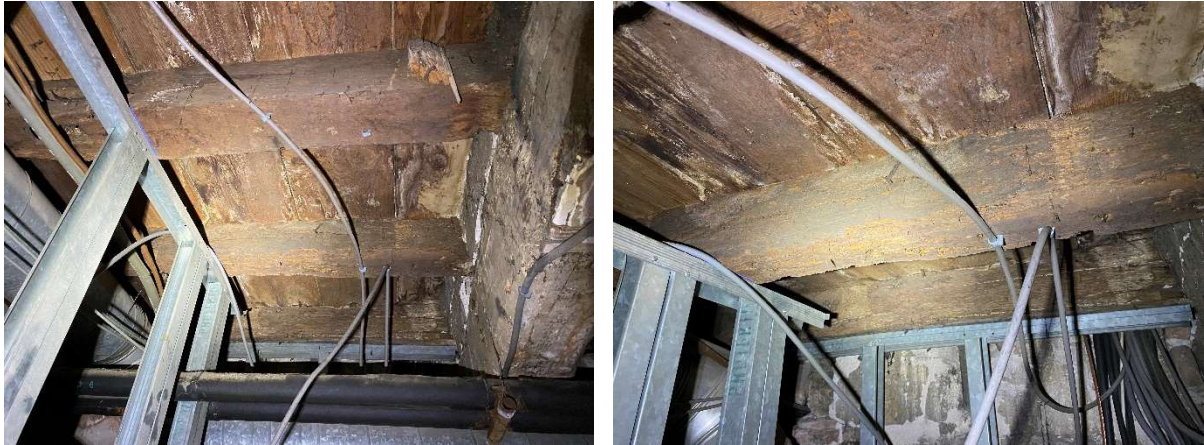
Photographie du plancher au droit de la zone « Archive 1 »
