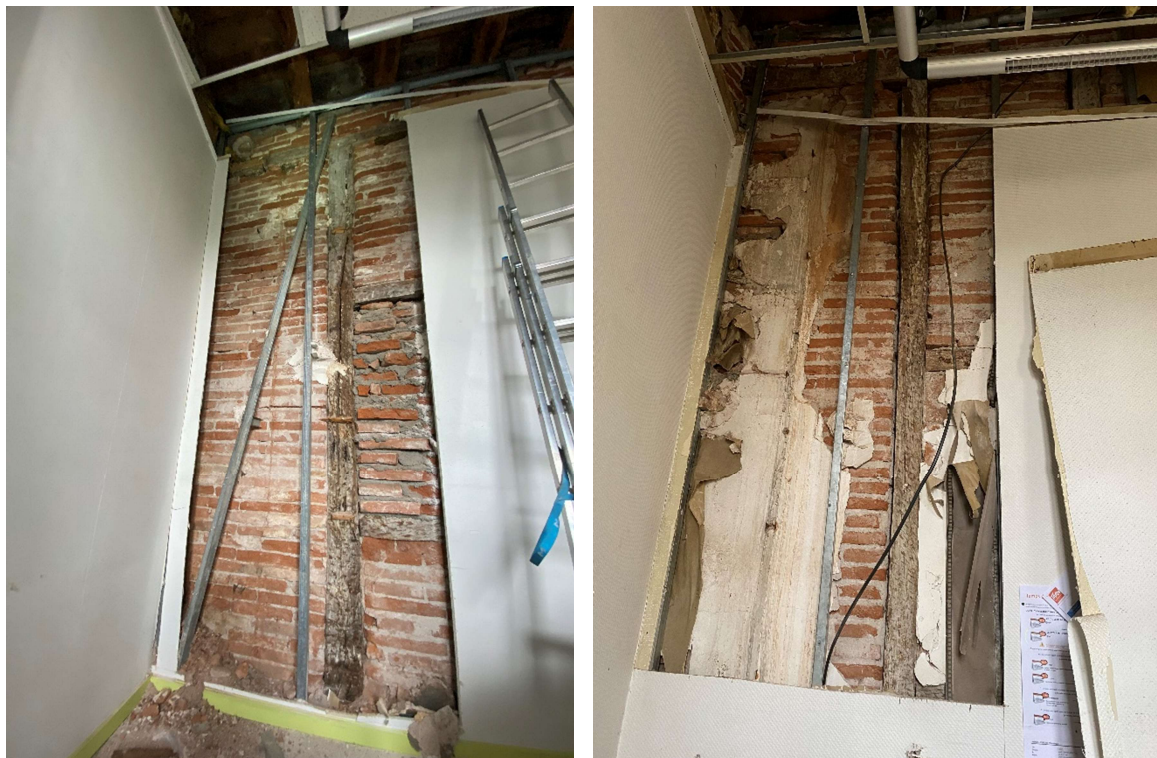
Photographies générales du mur en colombage depuis l'intérieur au 1 er et 2 e étage
