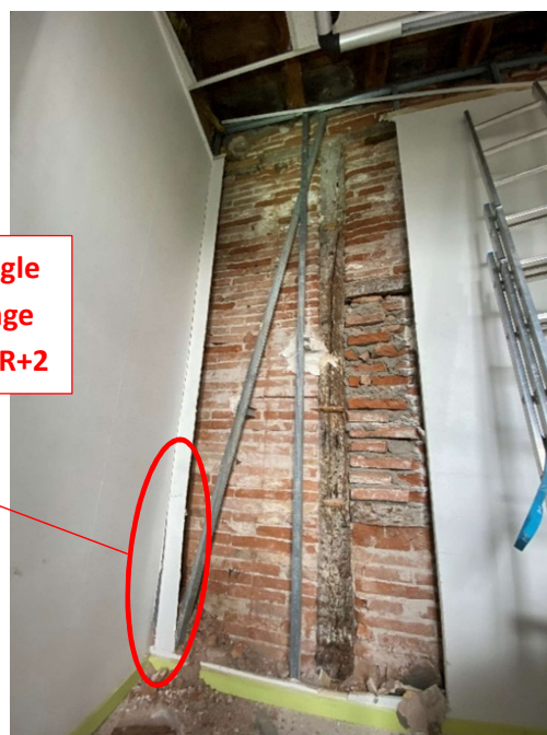
Colombage vertical dans l'angle gauche du bâtiment R+2
