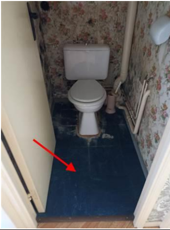
Photo n° PhA004 Localisation : 1er étage - Wc Ouvrage : 2. Planchers et plafonds - Planchers Partie d'ouvrage : Dalles de sol Description : Dalles de sol Bleu
