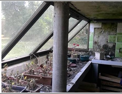
Photo n° PhA001 Localisation : Sous-Sol - Débarras 2 Ouvrage : Murs, Cloisons "en dur" et Poteaux (périphériques et intérieurs) Partie d'ouvrage : Entourages de poteaux (amiante-ciment) Description : Entourages de poteaux (amiante-ciment)
