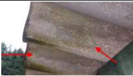
Photo n° PhA002 Localisation : Extérieur - abris de piscine Ouvrage : Substrats et revêtements Partie d'ouvrage : Parties accessibles Description : Plafond - solive + tole fibre ciment et fibociment Localisation sur croquis : oui
